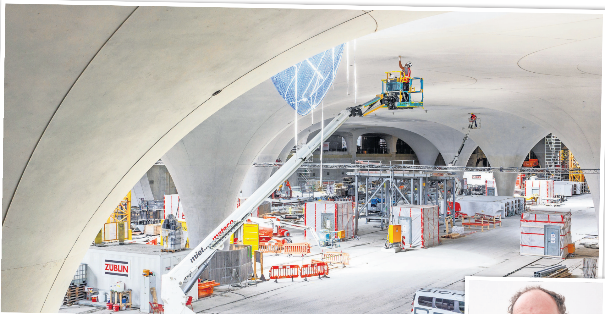
Ein beeindruckendes Beispiel zeigt sich auf der Großbaustelle Stuttgart 21. Dort werden die kelchförmigen Stützen bearbeitet. Foto: Sebastian Hopp
